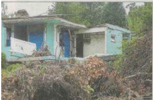
Kaputte Einrichtungen, eingerissene Mauern, weggespülte Gegenstände und eingeschlagene Fenster: Die Schäden sind enorm.
